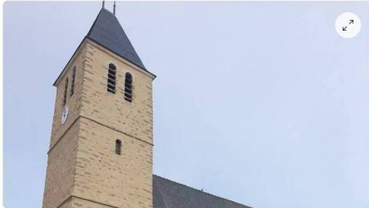
L'échafaudage de l'église a été démonté. Les travaux extérieurs sont terminés. | LE MAINE LIBRE
